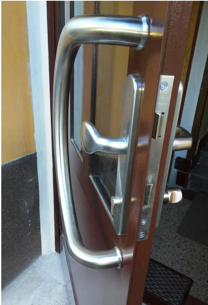
Detail na dveřích bezpečnostní kování, zámek K431 HOBES, nerez madlo, vložka FAB
