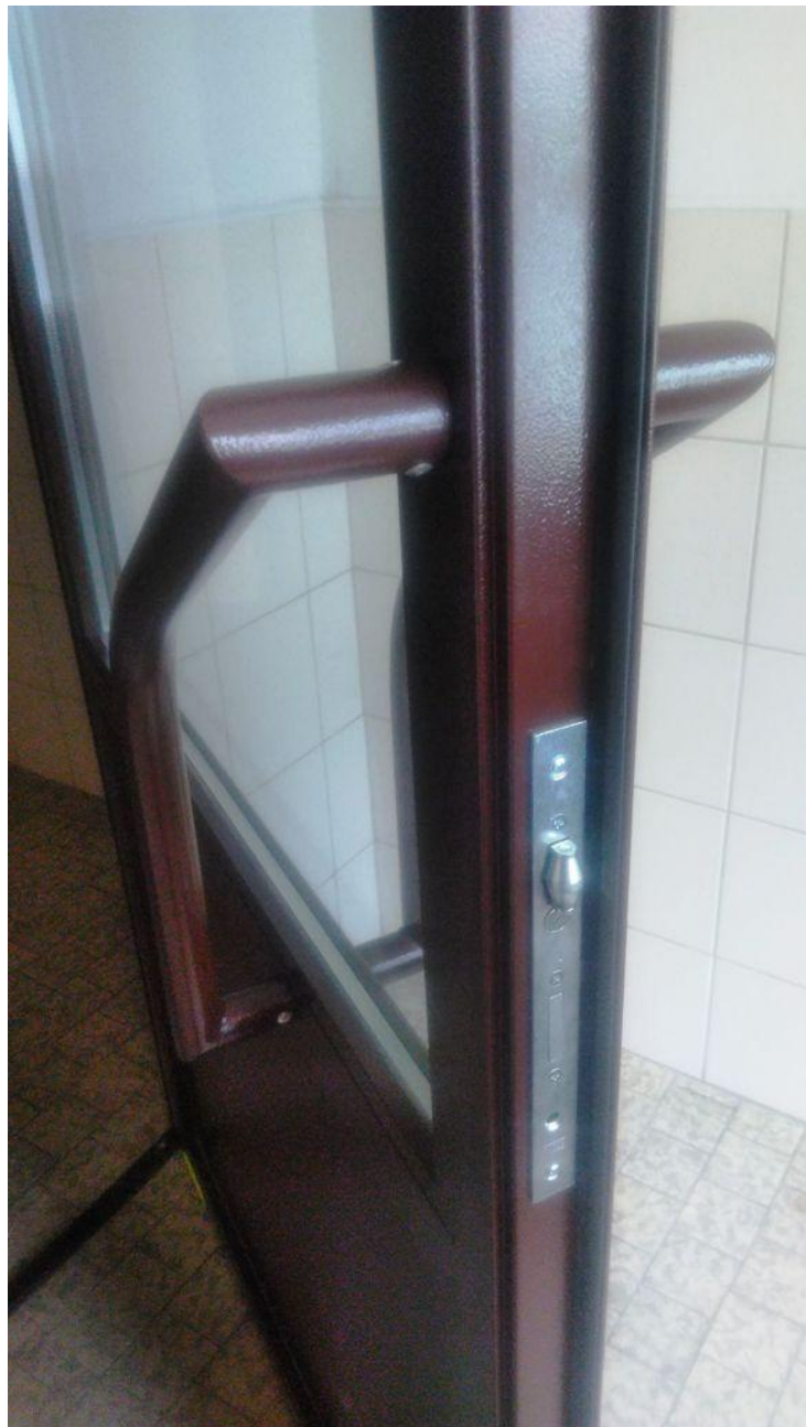
Detail vnitřní dveře – s válečkovým zámkem a ocelovým dvoumadlem
