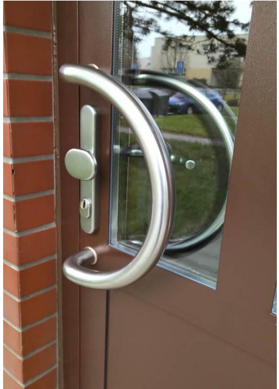
Detail na dveřích bezpečnostní kování, zámek K431 HOBES, nerez madlo, vložka FAB
